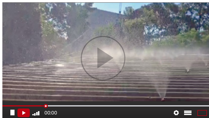
CLIMA CLEAN - Climatização por Evaporação com reúso da Água da Chuva nos telhados.
